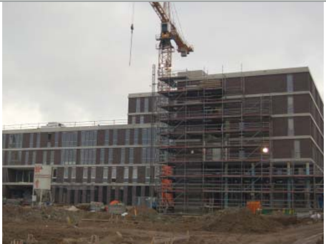
De nieuwbouw van zorgcentrum Ter Eyck staat in de steigers.
