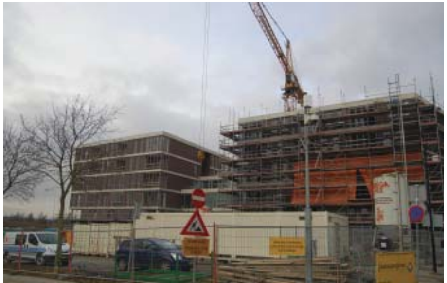
Het in aanbouw zijnde zorgcentrum Ter Eyck wordt in het voorjaar opgeleverd.
